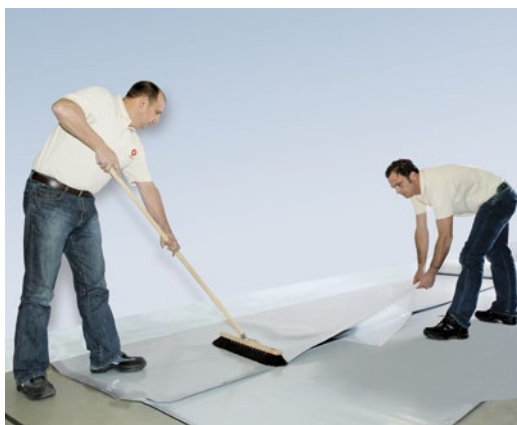
Schutzfolie seitlich herausziehen und Bahn blasenfrei andrücken
