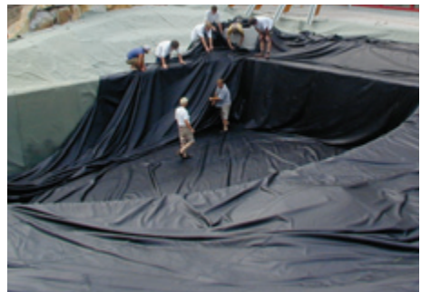
NOVOPROOF® TE als Dichtungsplane in einem Klärbecken
