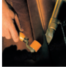
Thermofast® Fügetechnik mit Heißluftfön und Andrückrolle
