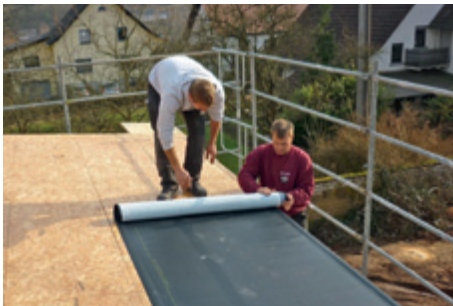
NOVOPROOF® SK wird am Dachrand ausgerichtet
