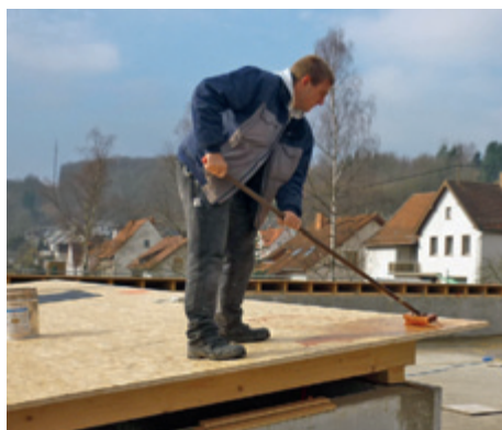
Aufbringen der Grundierung NOVOPROOF® G-SK
