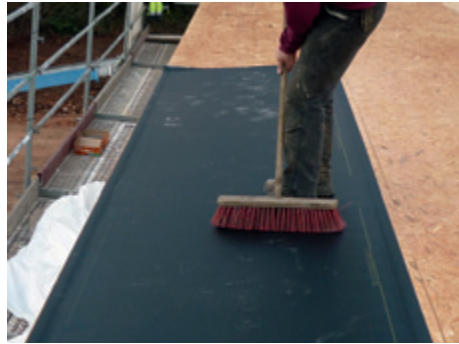
NOVOPROOF® SK wird hier auf die grundierte Holzwerkstoffplatte vollflächig aufgeklebt und mit einem Besen angedrückt
