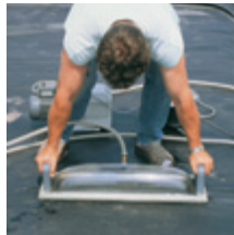
Prüfung mit Saugglocke
