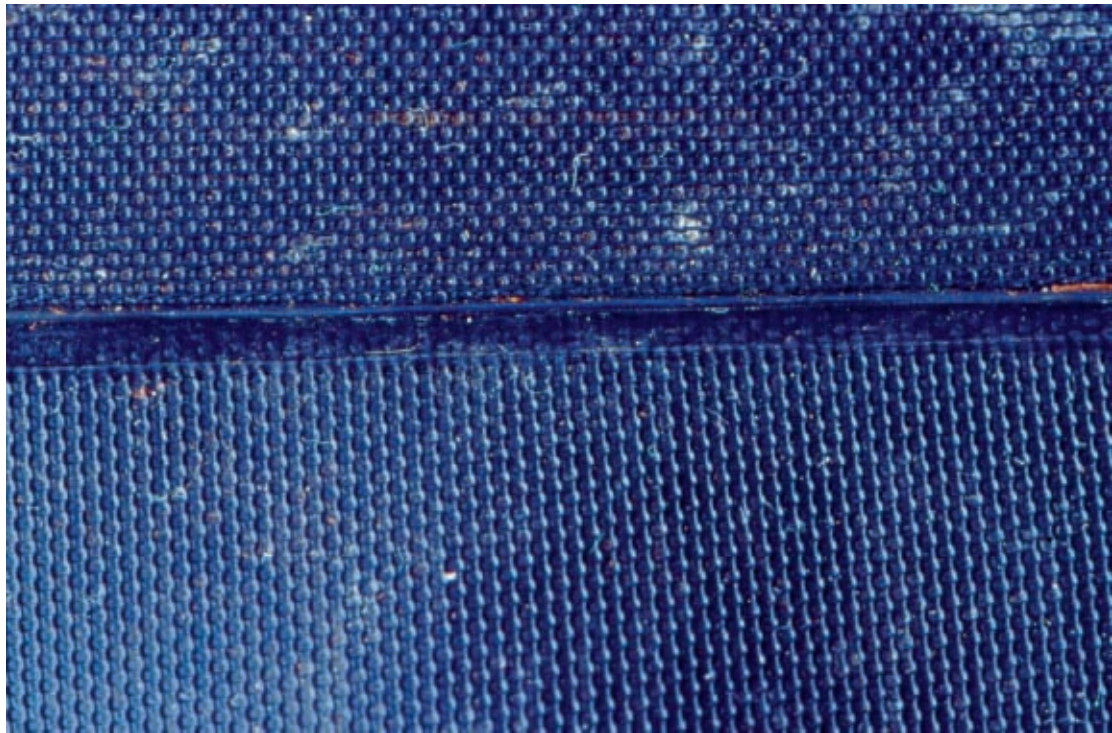
Abb. 3: Bahnoberseite mit Längs-Naht (Detail)
